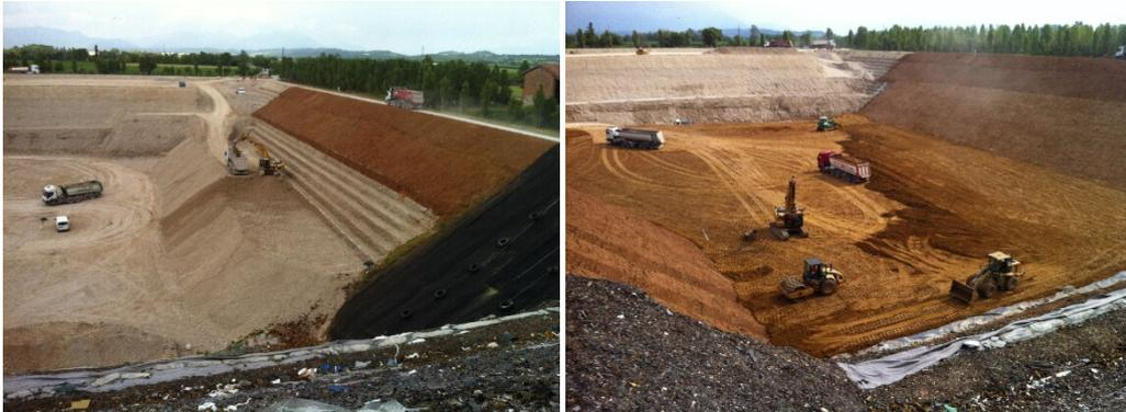
Posa del materiale impermeabilizzante sul fondo e sulle scarpate laterali
