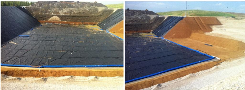
Posa del telo in HDPE sul fondo e sulle scarpate laterali
