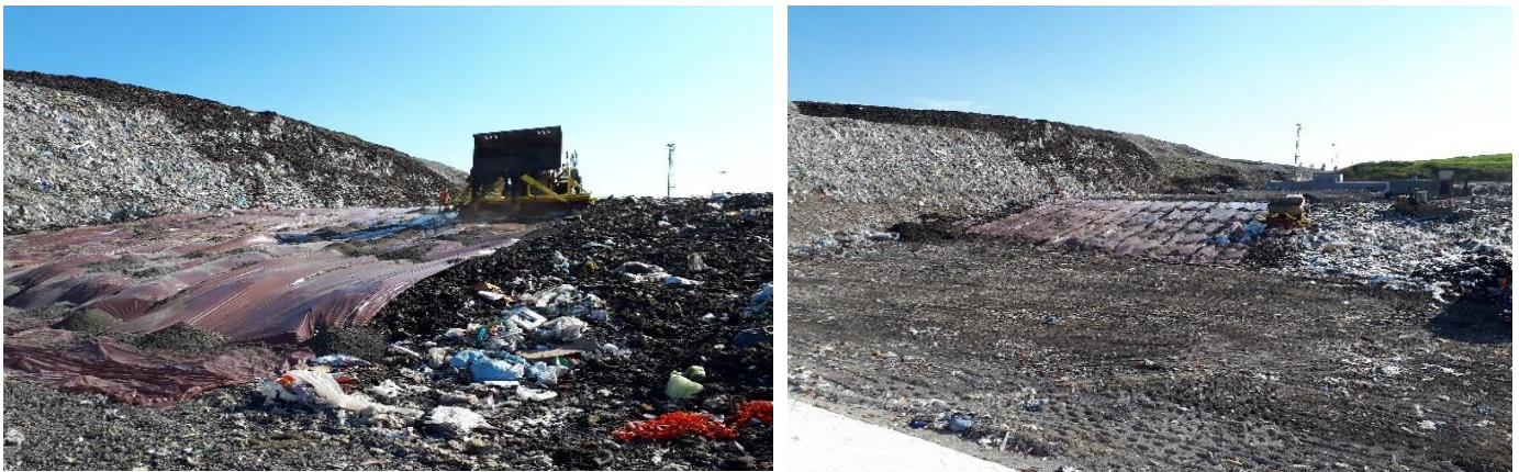
Dettaglio della fase di copertura
