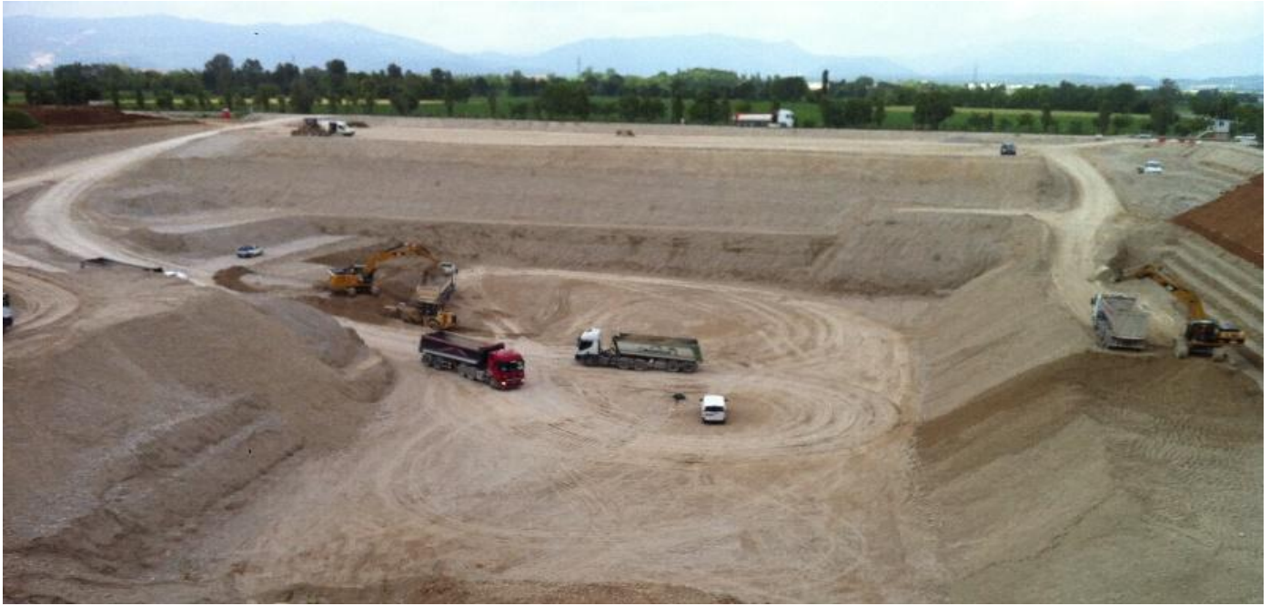
Figura 9 - Dettaglio delle operazioni di escavazione
