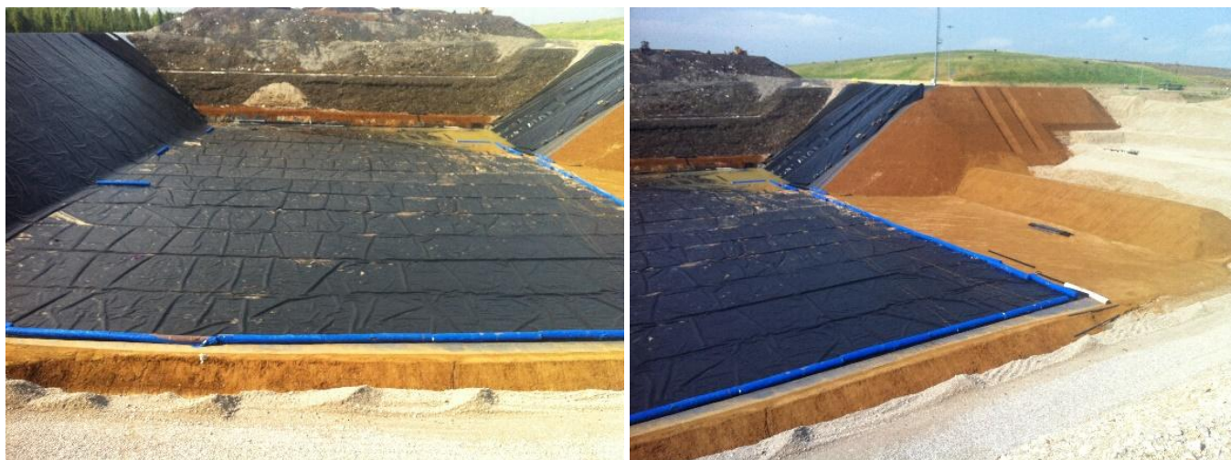
Figura 11 - Posa del telo in HDPE sul fondo e sulle scarpate laterali
