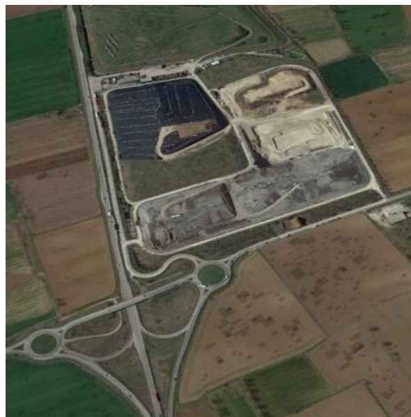
Figura 6 - Vista aerea della strada di accesso alla discarica di Bedizzole
