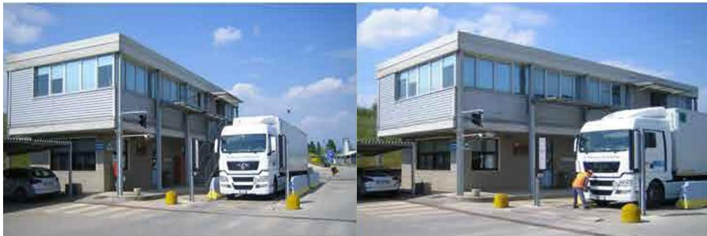
Figura 13 - Mezzi in ingresso all'impianto in fase di accettazione
