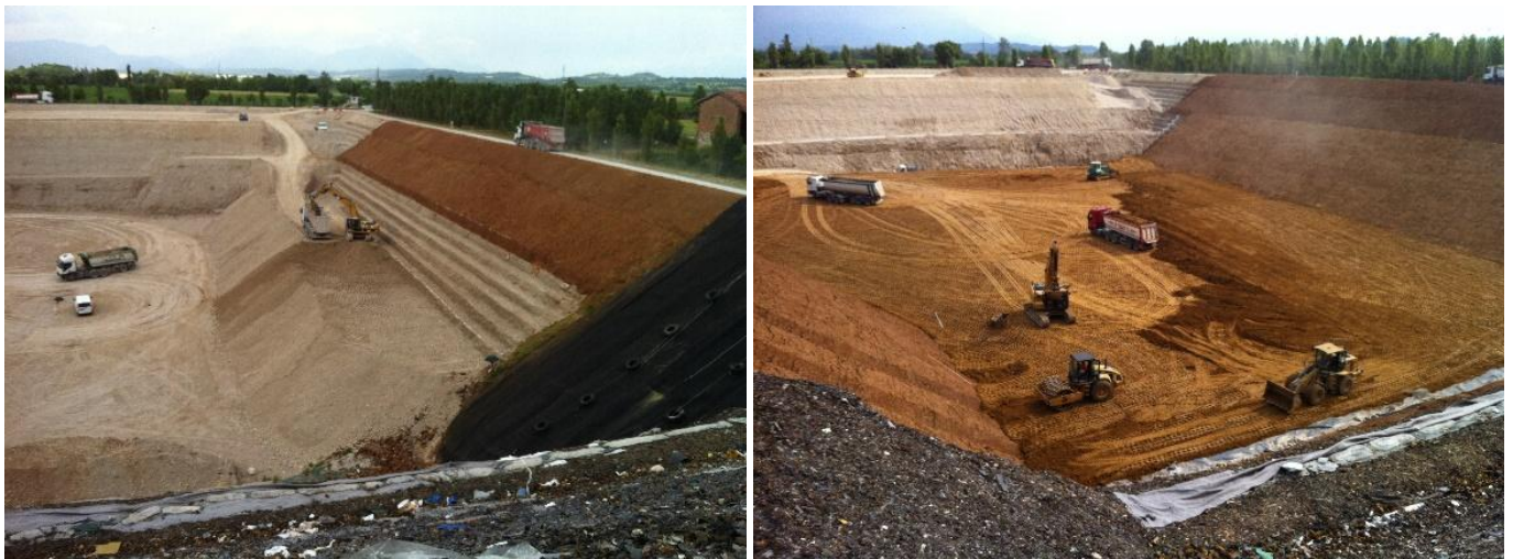
Figura 10 - Posa del materiale impermeabilizzante sul fondo e sulle scarpate laterali
