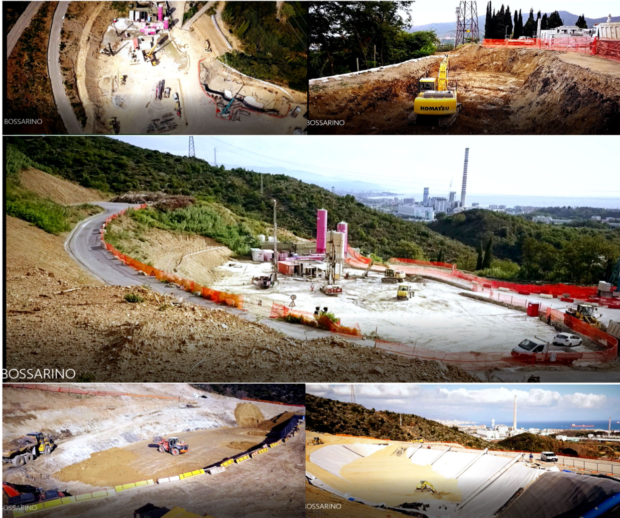
Figura 4 – Realizzazione della fase 1 dell'Ampliamento: Realizzazione di nuovi lotti sull'area della discarica
