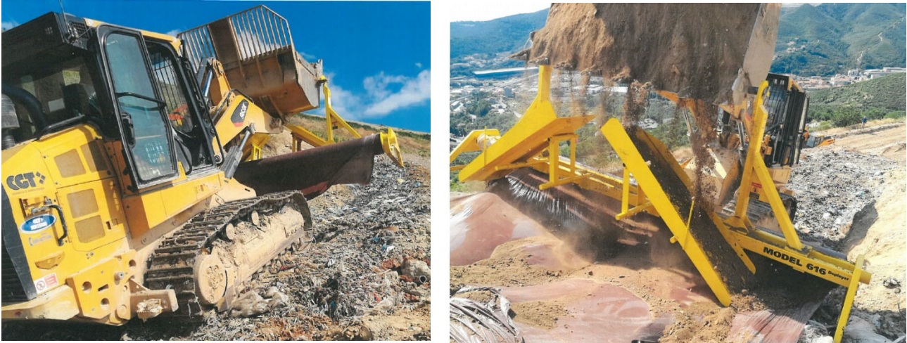
Figura 15 – Attività di copertura dei rifiuti abbancati
