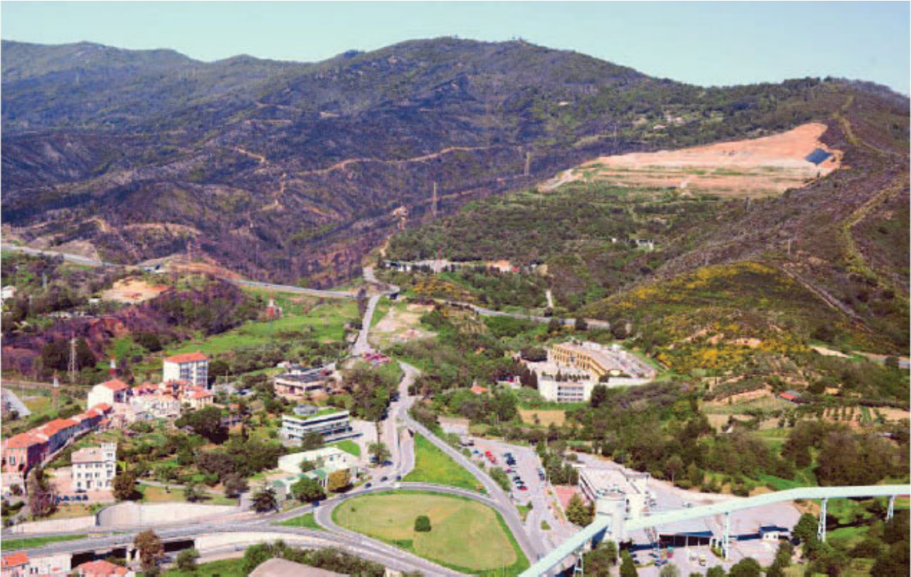
Figura 7 – Vista aerea della strada di accesso alla discarica di Bossarino
