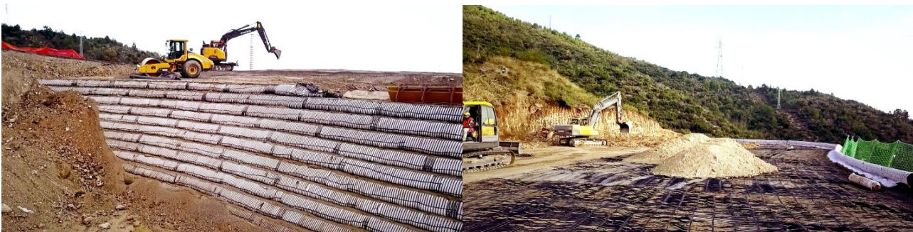
Figura 13 – Realizzazione delle terre armate
