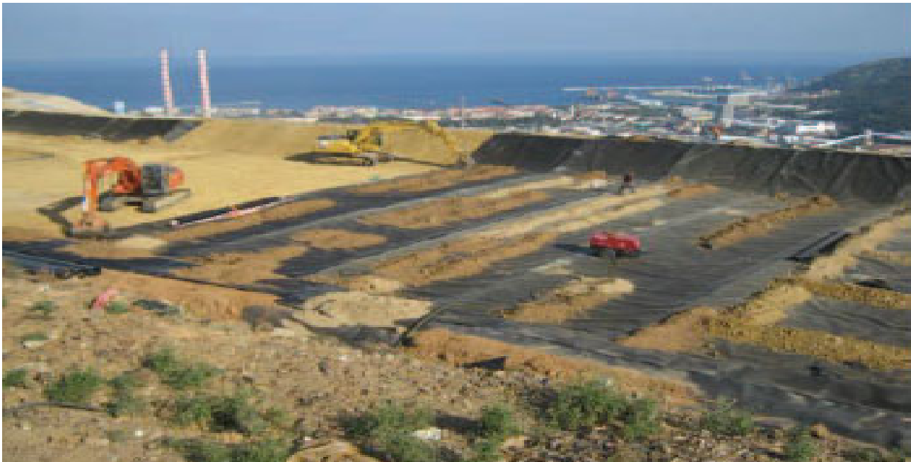
Figura 9 – Preparazione lotto di discarica
