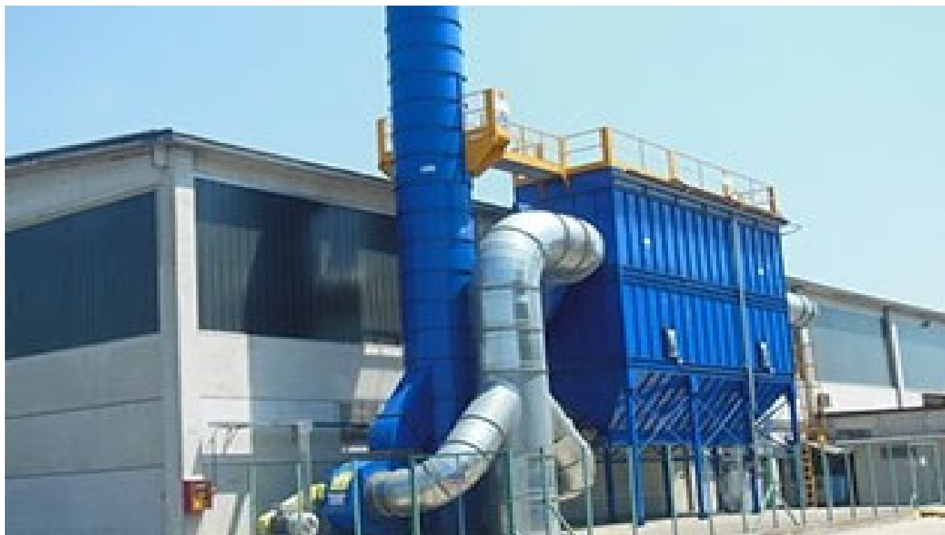
Figura 22 – Filtro a maniche: punto di emissione E1
