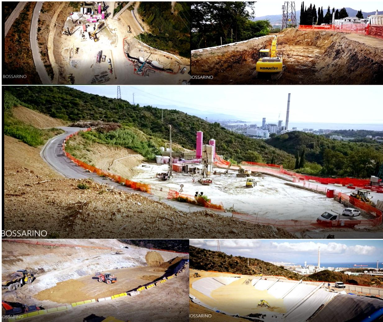
**Figura 4 – Realizzazione della fase 1 dell'Ampliamento: Realizzazione di nuovi lotti sull'area della discarica**
