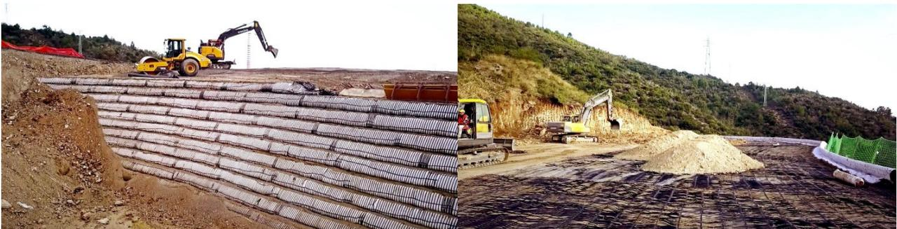
**Figura 13 – Realizzazione delle terre armate**
